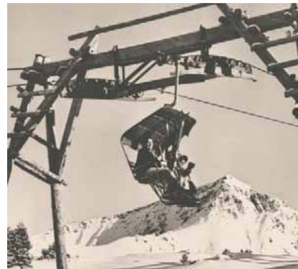
Die Saaner waren lange Zeit Bergbahn-Pioniere mit Beachtung von weither. Der erste Sessellift der Schweiz am Wasserngrat hing mangels Eisen an Holzmasten.
